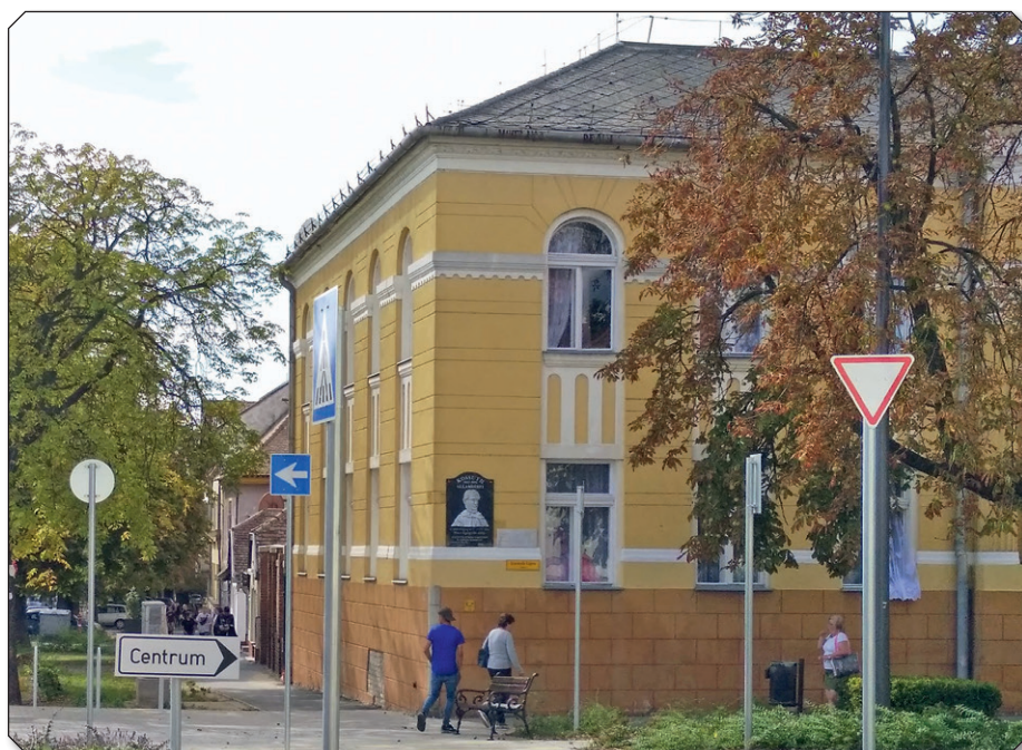
A Sümegi Járásbíróság megalakuláskor a Vármegyétől ingyenesen használatba kapott ún. „régi megyei házban” nyert elhelyezést. A rossz körülmények miatt 1913-tól már tervezték egy új bírósági épület felépítését, ám az építkezés csak 1927-ben indult meg, majd a következő évben át is adták a járásbíróság új épületét, amely napjainkban már nem az ítékezésnek ad helyet (Fotó: Sümegi Önkormányzat)
